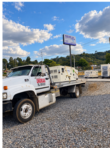
Traslado de generadores.
