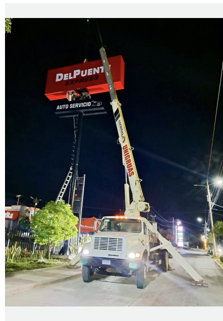
Apoyo a montajes en altura.
