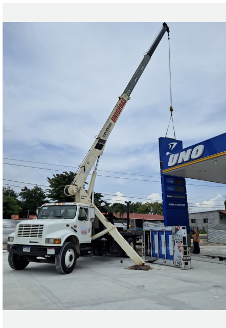
Instalación de elementos comerciales.
