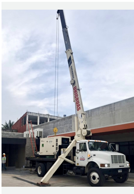
Movimiento de maquinaria.
