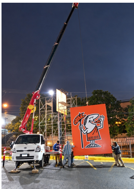
Instalación de elementos comerciales.
