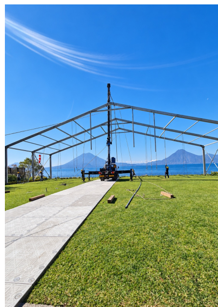
Montaje de estructuras metálicas.
